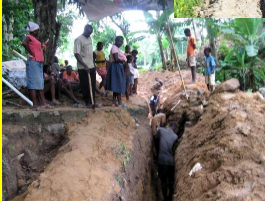
Installation des conduits d'adduction
