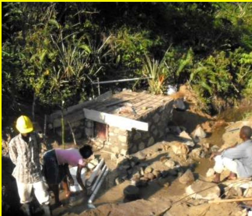
Construction d'une boîte de captage pour AEP
